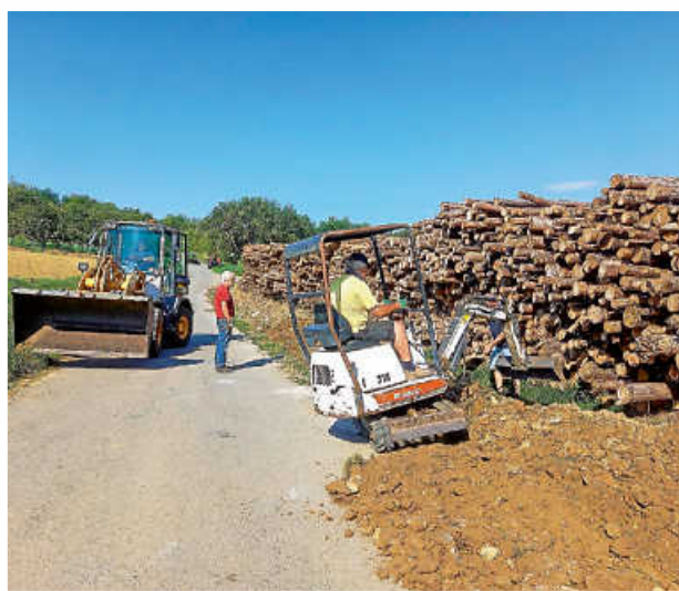
Zuschütten des Kabelkanals entlang des Weges.
