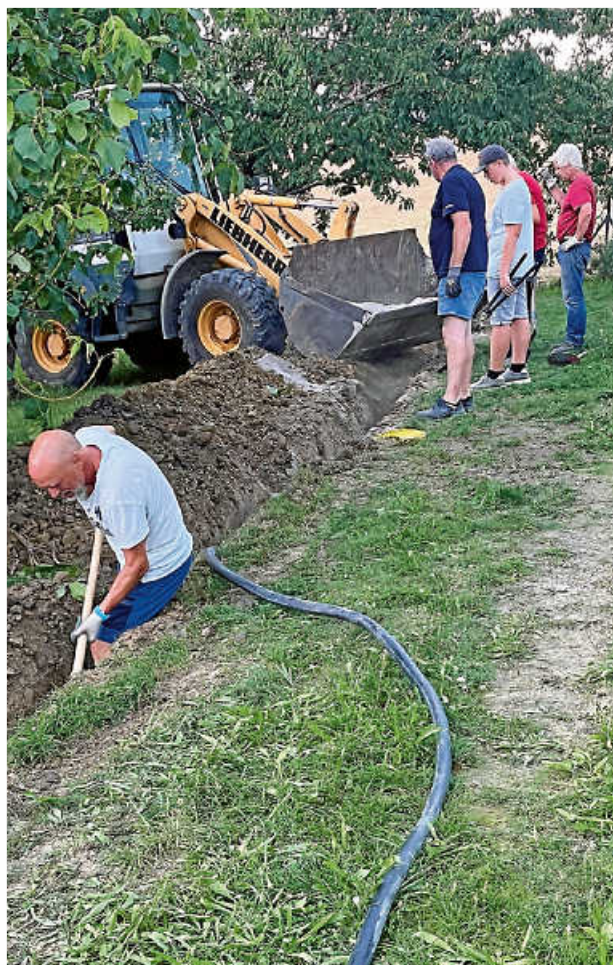
Verlegung des Erdkabels im Grabeland.
