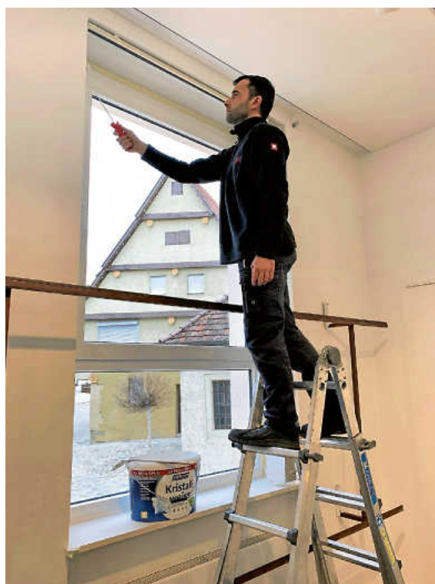
Hausmeister Sali Gashi verpasst der Galerie Sepp Veas einen neuen Anstrich. Foto: Susanne Kittelberger
