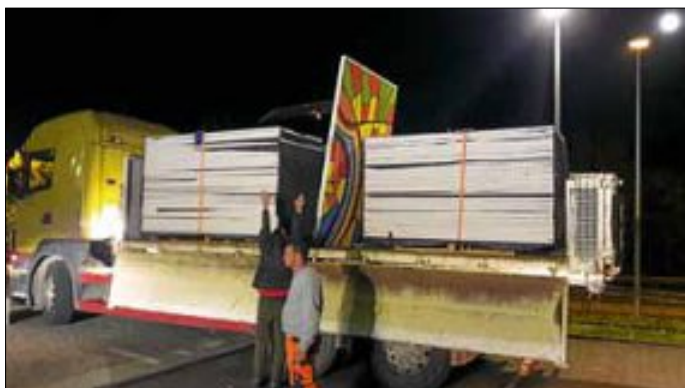
Ein LKW beladen mit 4 Paletten voller Wandelemente. Verladen und Transport geht hier nur mit professioneller Unterstützung: Wir danken an dieser Stelle sehr herzlich Schneider Garten- und Landschaftsbau!
