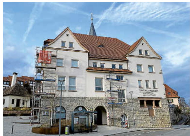
Das alte Schulhaus in Flacht ist derzeit an zwei Stellen eingerüstet.
